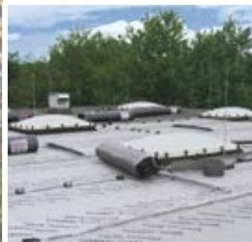
DELTA®-TERRAXX Schutz- und Drainagesystem für druckbelastbare Untergründe
