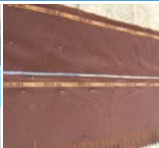
DELTA®-MS Couche de propreté, protection de murs enterrés, couche d'interposition drainante.
