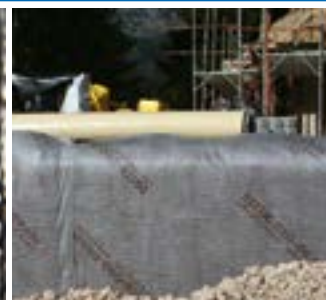
DELTA®-GEO-DRAIN Quattro Système de protection et de drainage quadri-couches pour revêtements d'étanchéité sensibles au poinçonnement.
