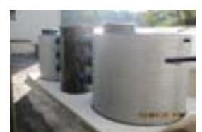
Fosses de pompage
