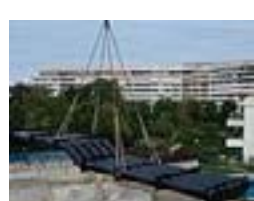
Puits canadiens / ventilations
